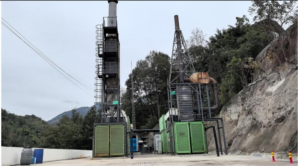
干法脱硫”+发电机组 SCR 脱硝+15m 排气筒
